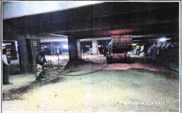
Fotografía 4. Se realiza el control de polvos mediante el riego del suelo expuesto.
