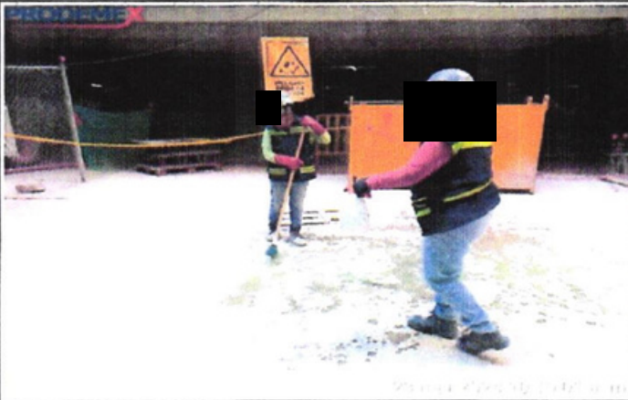
Fotografía 3. Se riega el área previo a barrer para reducir la propagación de polvos.
