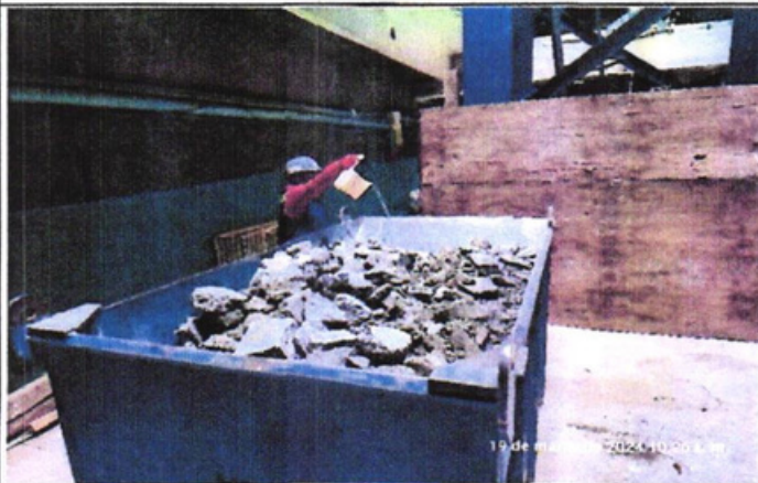
Fotografía 5. Se humedece con agua tratada el escombros previo a su retiro.
